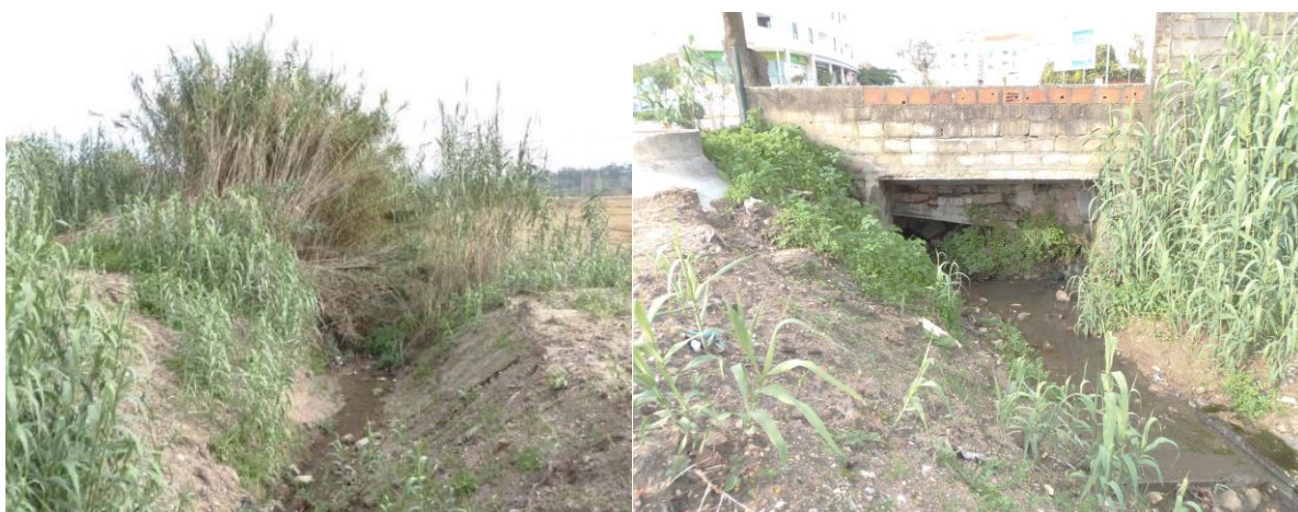
Figura 2 – Aspeto da linha de água associada à BH1 (esq.), não representada em carta militar, que será regularizada e da PHe (dir.).
